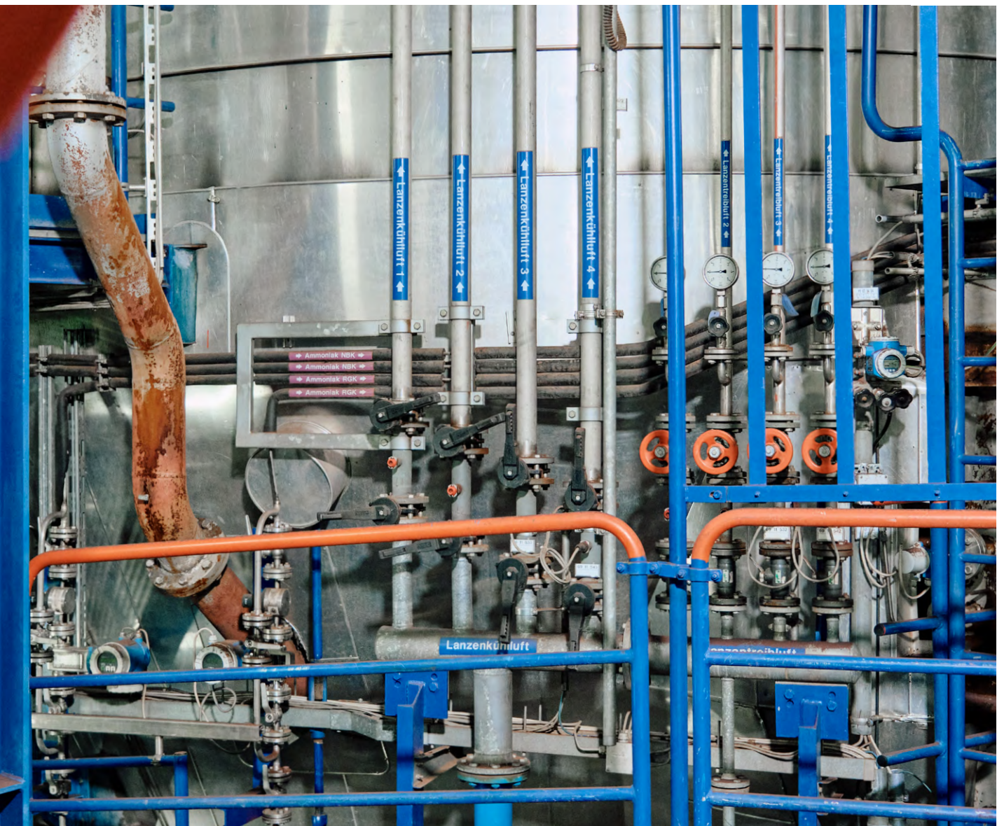
Die Schlammverbrennungsanlage ist deutlich über ihre ursprünglich vorgesehene Lebensdauer hinaus im Einsatz.
