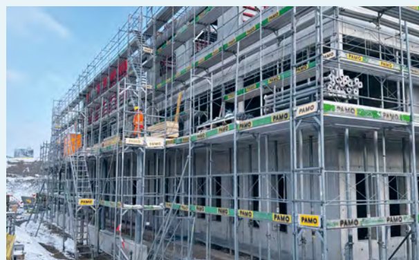
Das viergeschossige Betriebsgebäude nimmt schon im Jahr 2023 Formen an.
