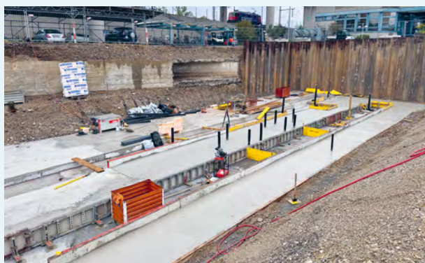
Das Fundament verschwindet unter den Bodenplatten.
