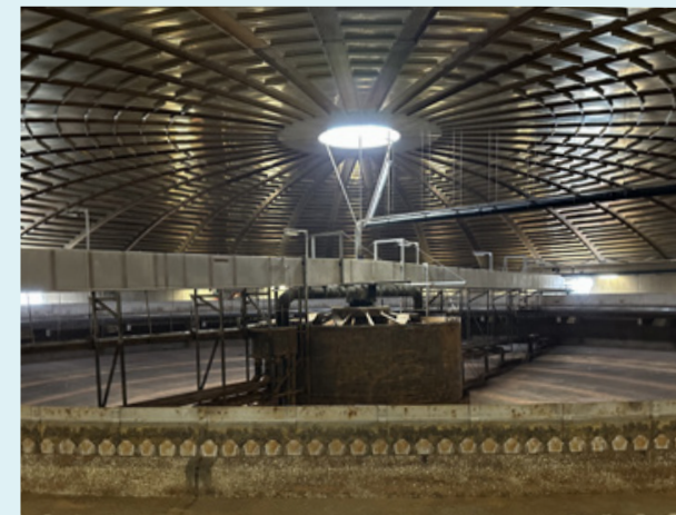
Altes Nachklärbecken, bereits trockengelegt und zum Abbruch vorbereitet.
