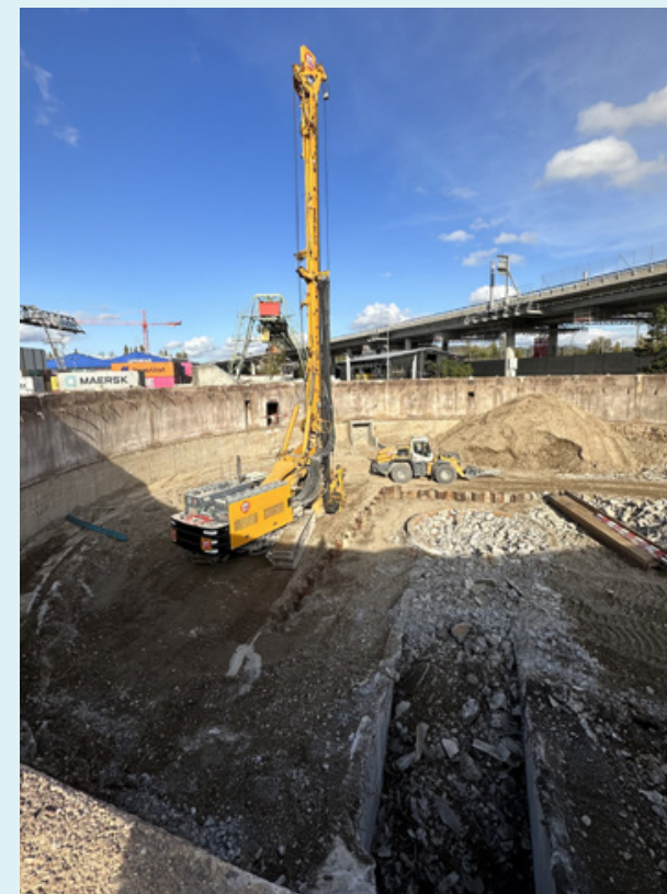
Der Abbruch hat begonnen; noch sind die letzten Strukturen der früheren Anlage sichtbar.
