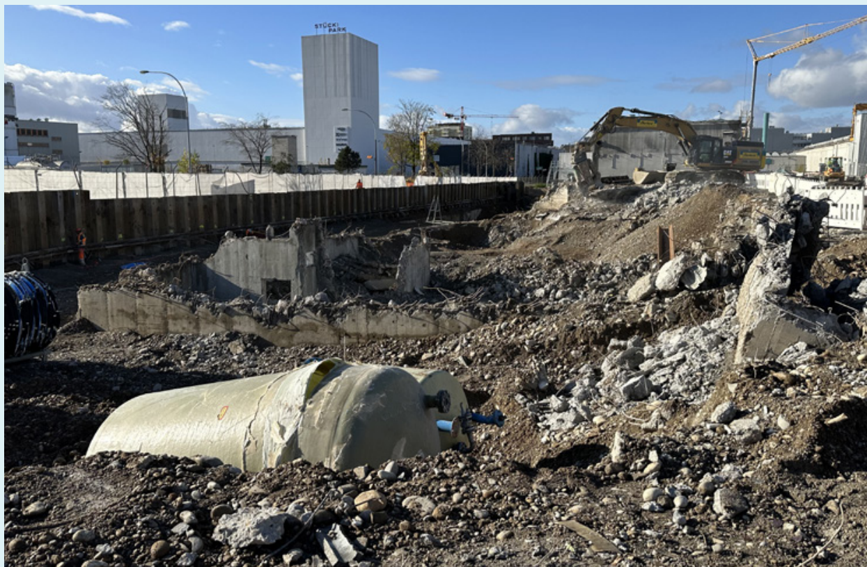
Von der ehemaligen Sandfang-Anlage ist nicht mehr viel zu sehen.
