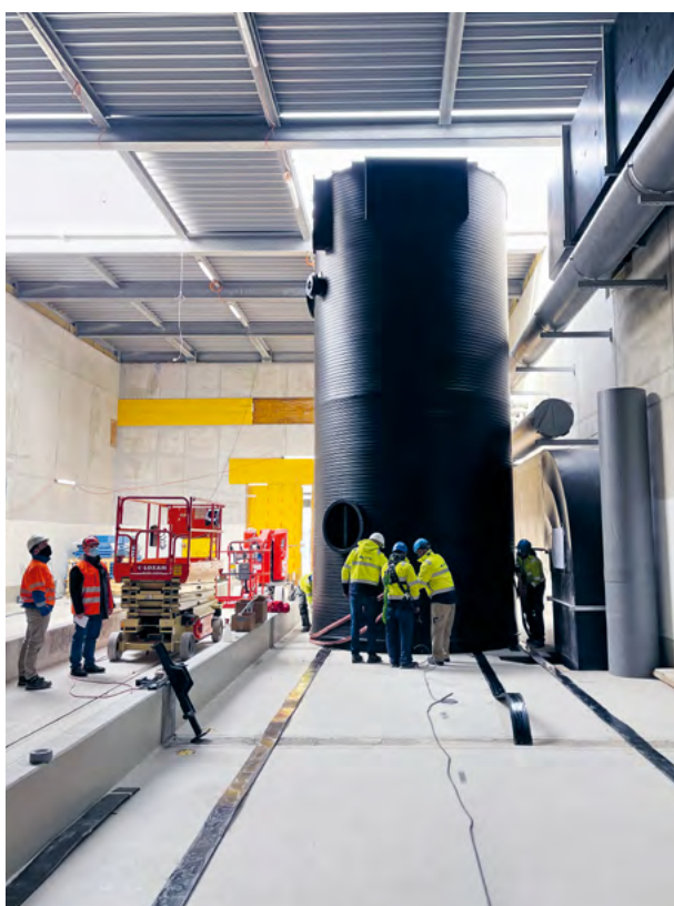
Der Waschturm steht. Da es nur einen dafür geeigneten Durchgang gibt, besteht die knifflige Aufgabe darin, die Türme im Innern so zu platzieren, dass am Schluss alle vier Waschtürme am richtigen Ort stehen.
