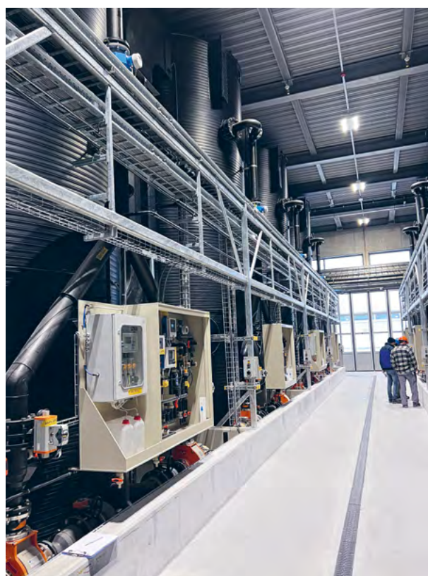
Die Bauarbeiten für die neue Abluftbehandlung sind beendet. Im Vordergrund sind die Bedienkästen angebracht, dahinter stehen die vier Waschtürme. Die Kamine sind hinter den Türmen und somit nicht mehr sichtbar. Die neue Abluftbehandlung ist eine Grundvoraussetzung, damit die neue ARA Basel in Betrieb genommen werden kann.
