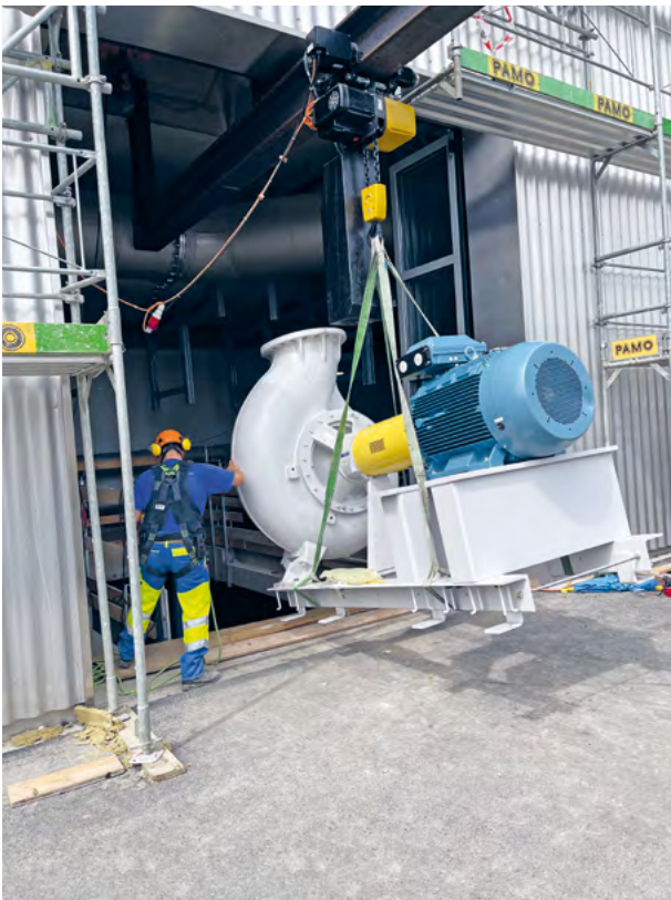
Eine der zehn Pumpen wird über die Montageöffnung in den Kopfbau der «Biologie» angeliefert.
