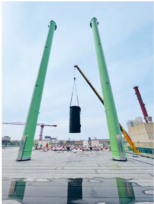
Im Vordergrund befinden sich die beiden installierten Kamine. Im Hintergrund transportiert ein Kran einen der Waschtürme ins Gebäude.
