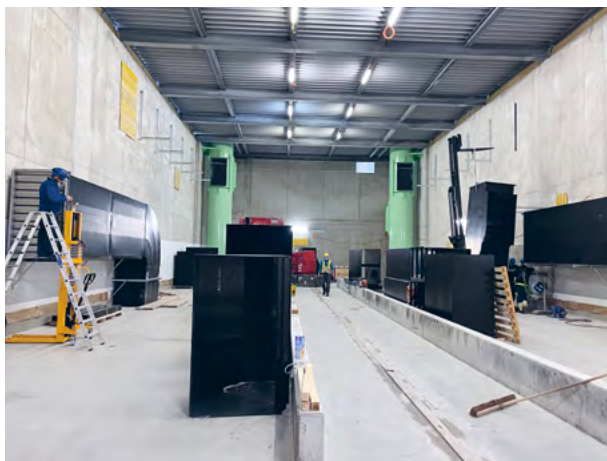
Jetzt sind beide Kamine im Gebäude installiert.
