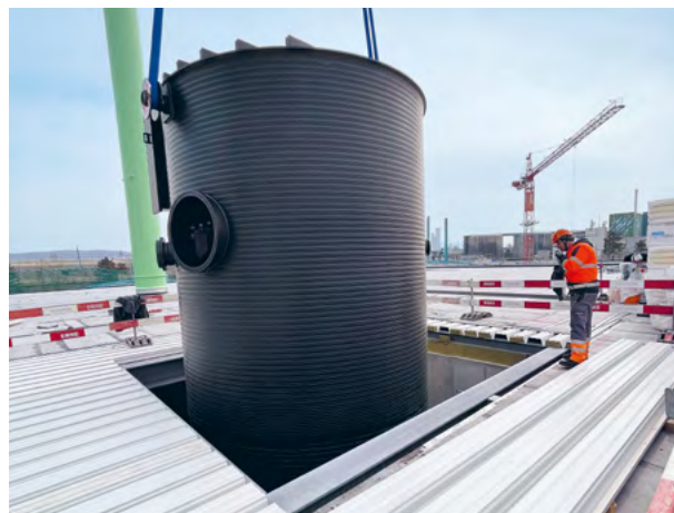
Der Waschturm muss durch den relativ engen Durchgang ins Innere des Gebäudes gelangen.
