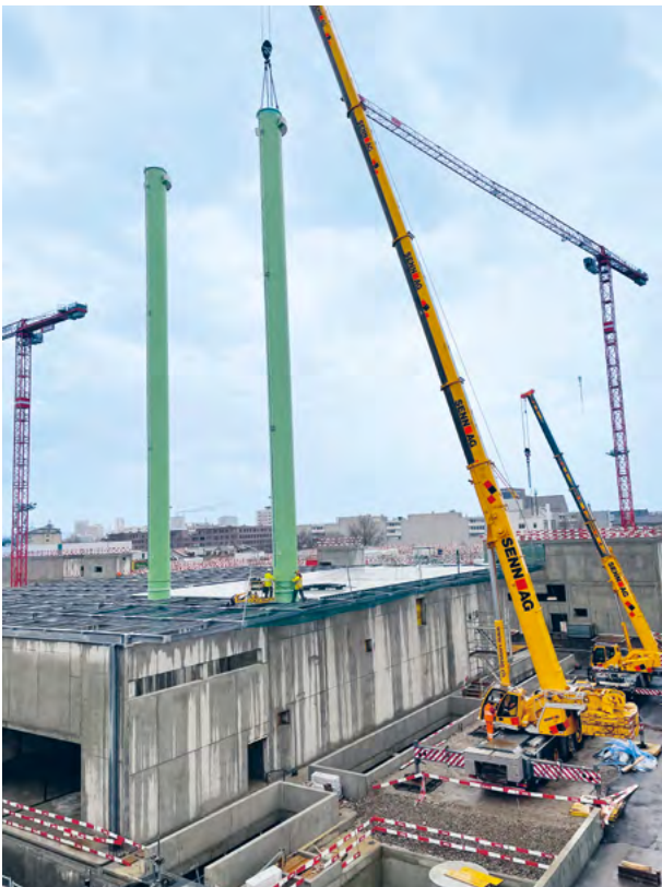
Auf diesem Bild sind zwei Kamine, eines davon ist bereits installiert.
